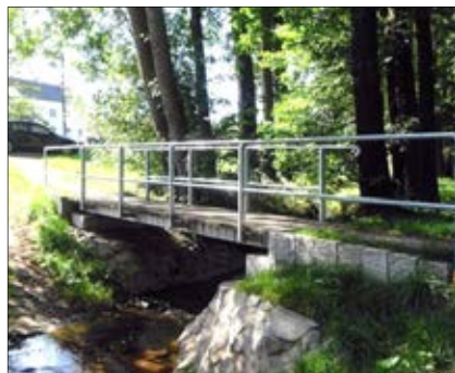
Ersatzneubau Fußgängerbrücke über den Koberbach in Rußdorf
